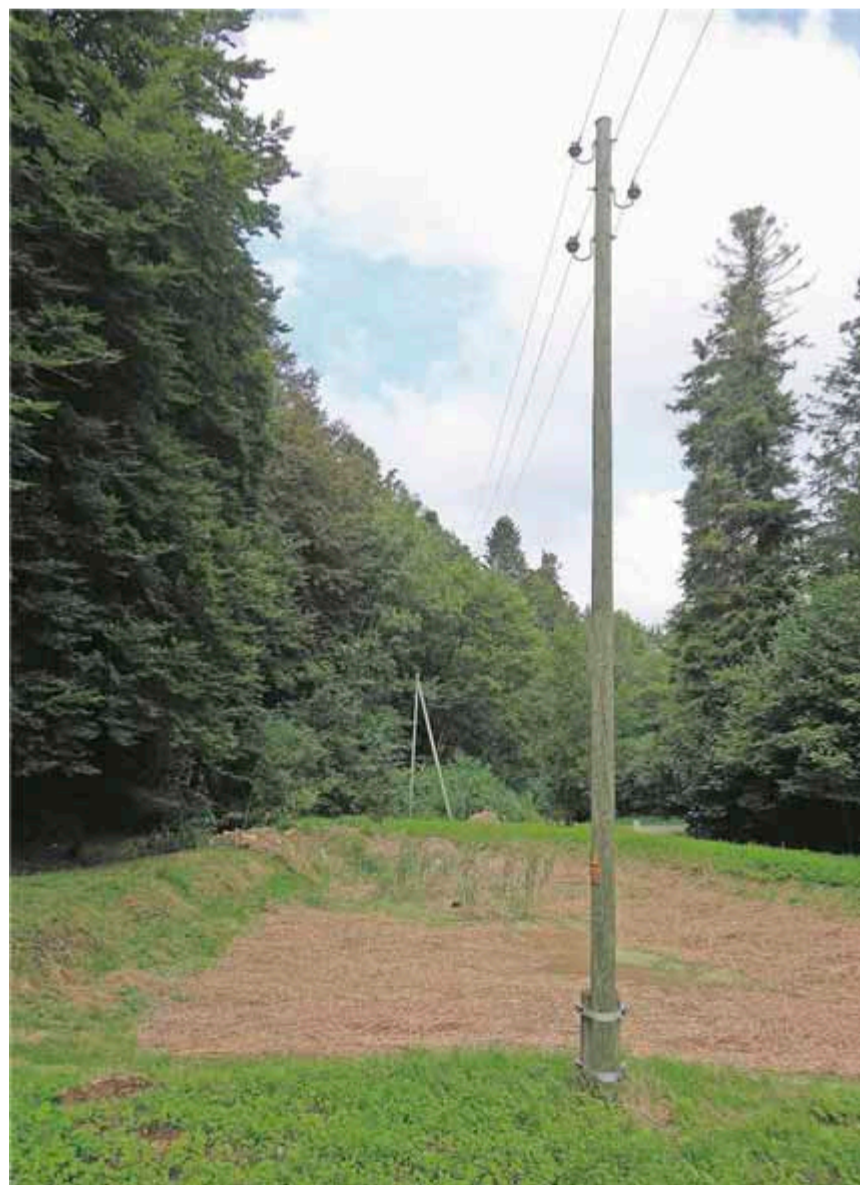
Dieses Bild bei den Wittelweihern in Oberhof soll bald einmal der Vergangenheit angehören: die Stromleitung wird in den Boden verlegt. (CHR)
